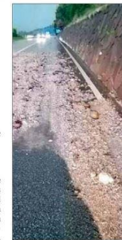
Die Hauptstraße zwischen dem ehemaligen Kartheiner Hof und dem Restaurant Ritterhof wurde durch Schutt und Geröll verlegt. FF Kaltern/Markt
